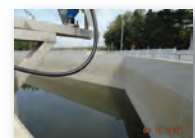
บ่อดักตะกอนก่อนระบายน้ำออกนอกพื้นที่โครงการ
