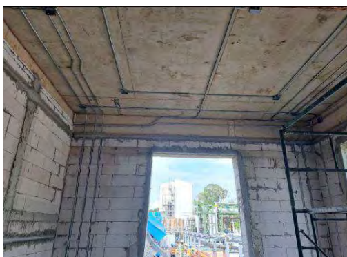
งานเดินท่อสายไฟในอาคารสำนักงาน
