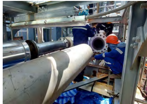
ติดตั้งท่อไอน้ำผ่านระบบควบคุม
